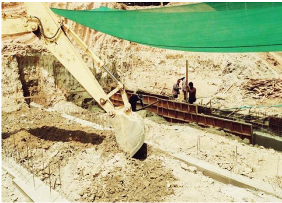
ก่อสร้างฝายทดน้ำขนาดสันฝายสูง 4.00 เมตร ความกว้าง 21.00 เมตร ความยาว 36.00 เมตร
