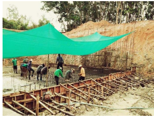
ก่อสร้างฝายทดน้ำขนาดสันฝายสูง 4.00 เมตร ความกว้าง 21.00 เมตร ความยาว 36.00 เมตร
